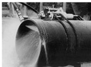
Figura 8 – Corte por jacto de água com abrasivo de tubagem (OSPREY®)
