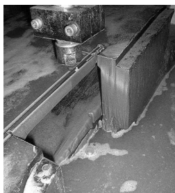
Figura 7 – Corte por jacto de água com abrasivo de chapa de aço para substituir no casco (desenvolvimento comercial: DIAJET®)
